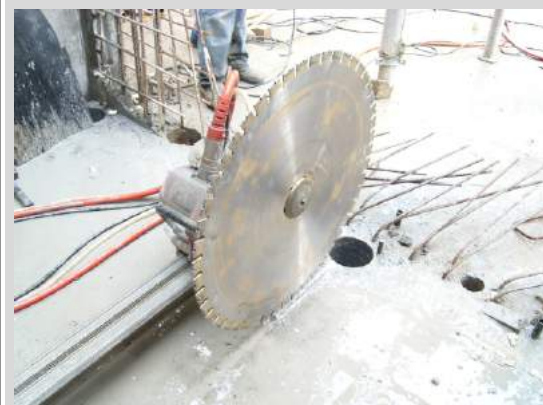
Cięcie piły ścienną
