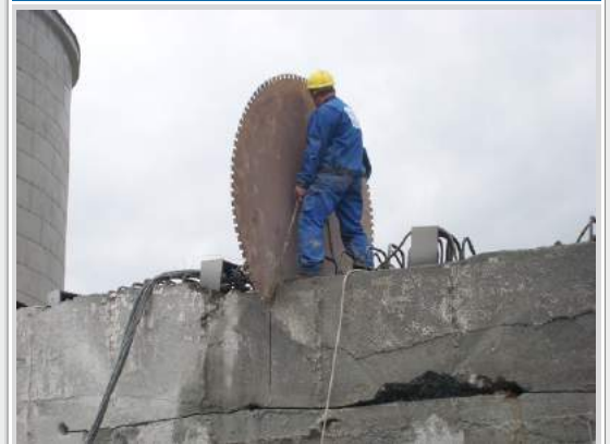
Cięcie piły ścienną
